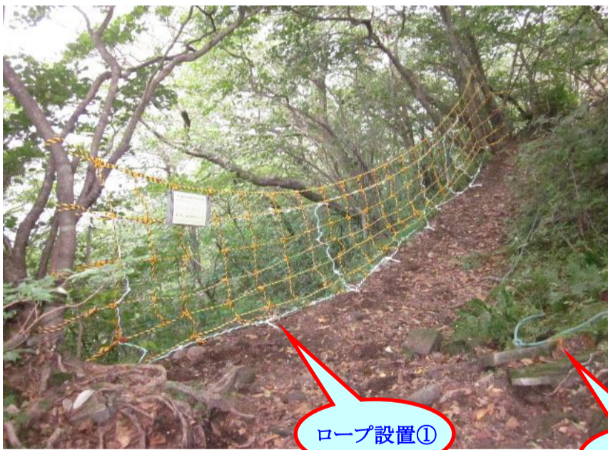
ネット方式に変更、山側にもロープを設置
